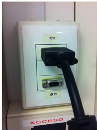
*Figura 6: Dettaglio porte VGA*
